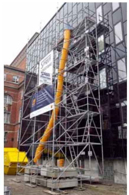
Die Spree Gerüstbau GmbH bietet das gesamte Spektrum an Gerüsten – qualitativ hochwertig und sicher.
