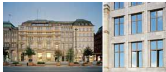
Die Stahl- und Edelstahlprofile des Systemgebers sorgen unter anderem im Haller-Haus in Hamburg für Sicherheit.
