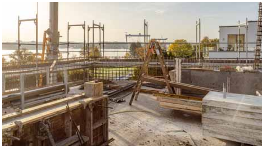
Baustelle in Kiel-Düsternbrook.
