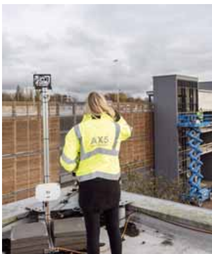
Baustelle in Stralsund.
