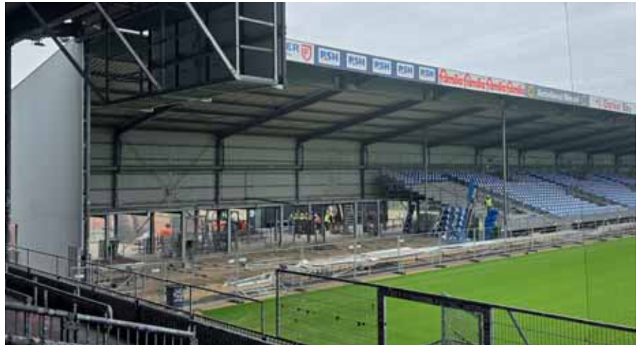
In nur vier Wochen wurde die Nordtribüne zurückgebaut: Zunächst die Technik, Sitzschalen und Tribünenböden, ...
