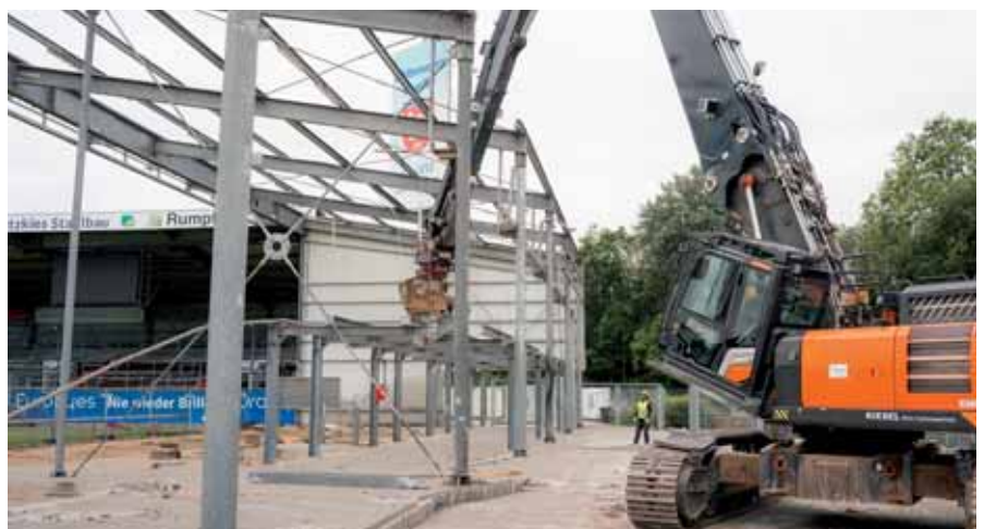
...und letztlich das Stahlgerüst.
