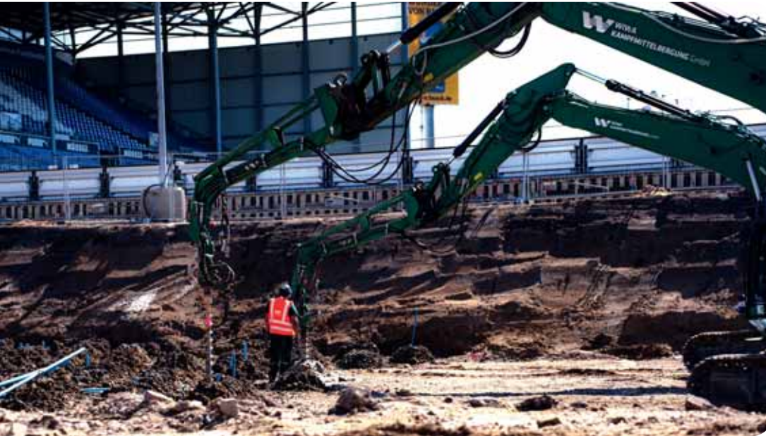
Der Kampfmittelräumdienst bei der Arbeit auf der Stadion-Baustelle.
