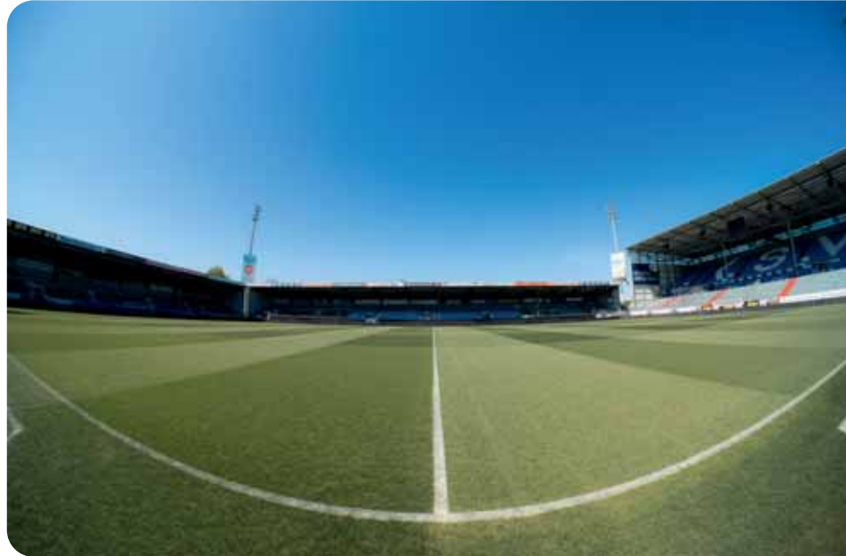
Der Blick ins Holstein-Stadion vor dem Umbau-Start.
