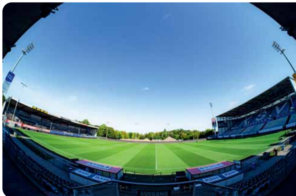
Das Holstein-Stadion nach mehr als 100 Tagen Baustelle.
